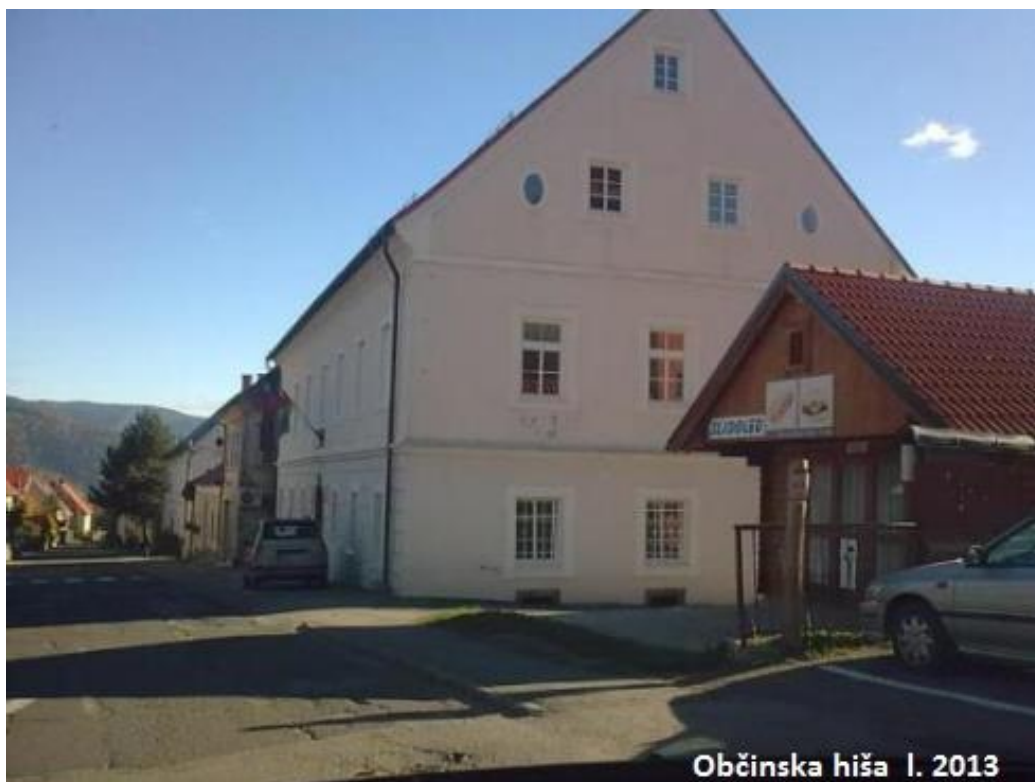
Slika 16: Občinska stavba danes.
