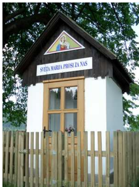
Slika 52: Čevnikova kapela na Zg. Kapli
